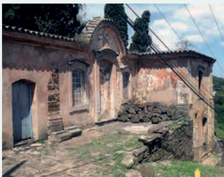
Figura 6 | Ruínas das instalações onde funcionou o Hospital Militar de Vila Rica
